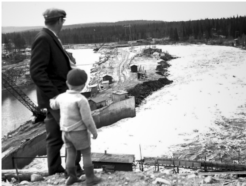
Kuva 7. Hyrynsalmen kunnan rakennustarkastaja Kalle Ojankangas ja poika Seitenoikean rakennustyömaalla. Kuvaaja tuntematon. ©Kalle Ojankankaan perikunta.
